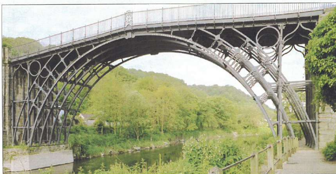
Puente de Coalbrookdale o Puente de Hierro, Telford, Reino Unido
