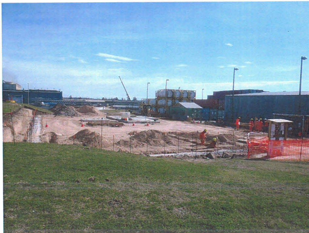
Figura 103: Obras de ampliación en la zona de plantas químicas.
