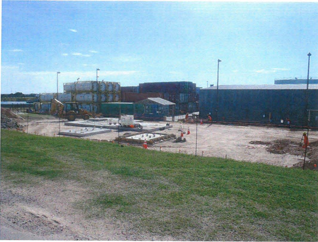
Figura 104: Obras de ampliación en la zona de plantas químicas.
