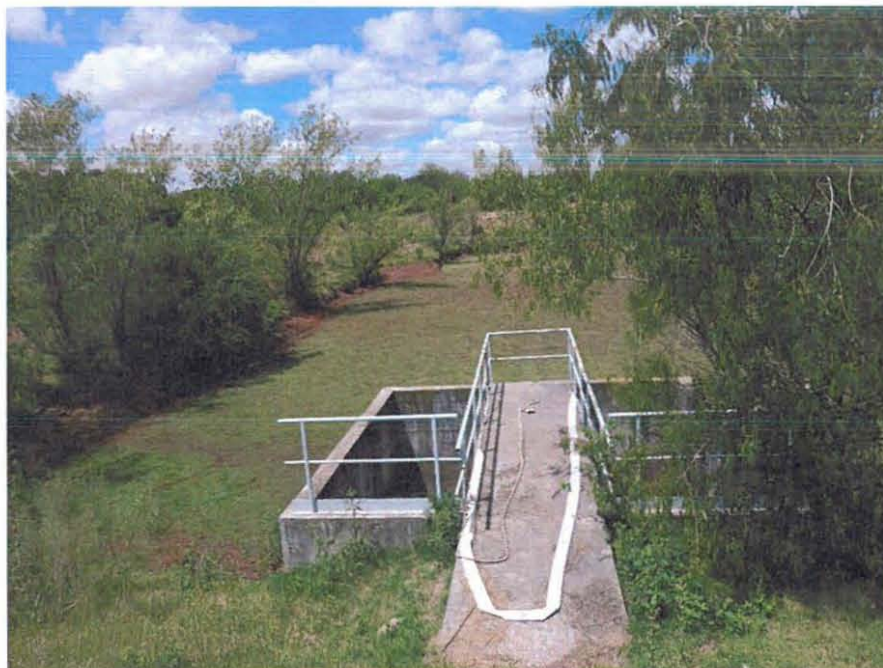
Figura 106: Tareas de vaciado de Pileta N°2 (Subestación) constatada durante el ingreso desarrollado en el mes de noviembre de 2023.
